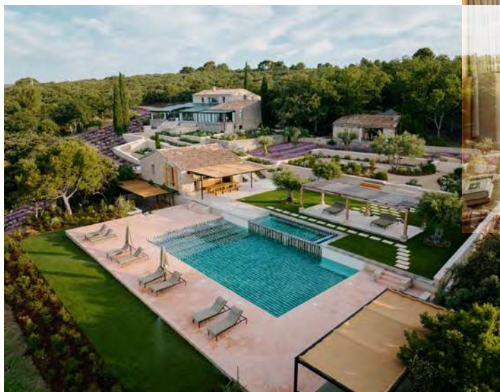
Les Hauts de Gordes - © Drone Iconic House
